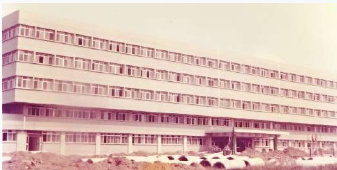
▲ 66 年中正一路醫療大樓完工正面。
