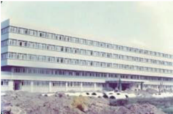
醫療大樓施工實景。
