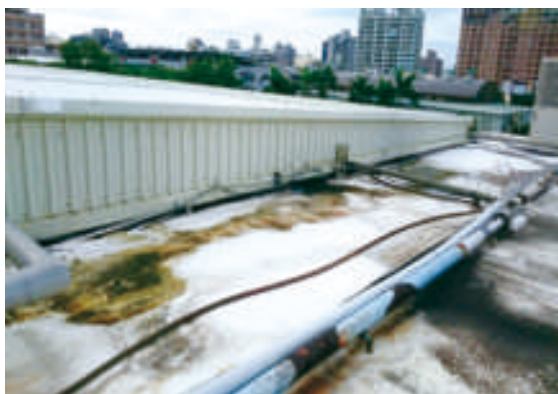
圖 9：伙房屋頂防漏工程整修前
