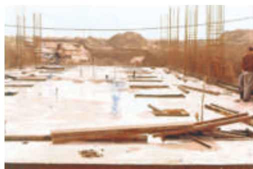
地下室東翼上夾層 RC 完成
