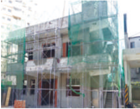
圖 3：整修中建物外觀
