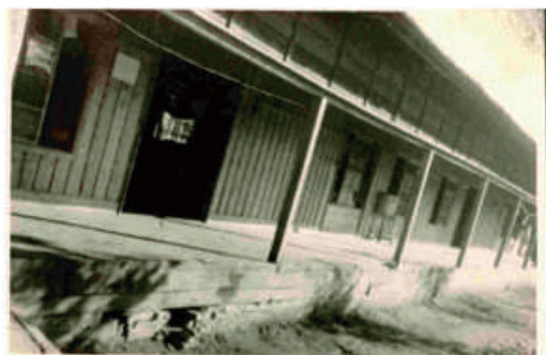
▲ 44 年，病房走廊腐朽、坍塌情形。(之二)
