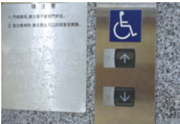
圖 11：電梯內外均設置點字導引。
