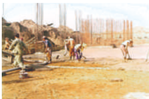
地下室地坪灌漿
