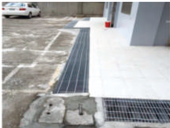
圖 11：整修後男醫護宿舍外觀走道
