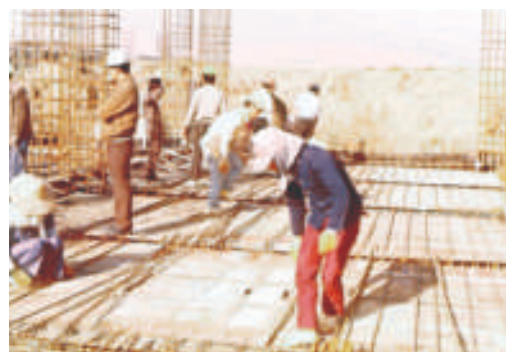
地下室東翼地坪配筋
