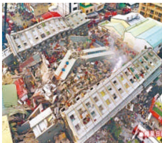
圖 2：臺南市永康區永大路 16 層樓高的「維冠金龍大樓」倒塌。（翻攝自蘋果日報）
