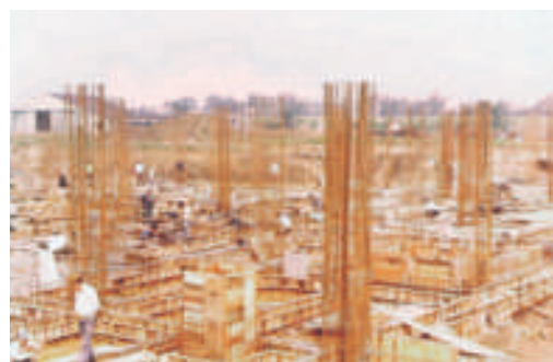
中央地下室地坪配模
