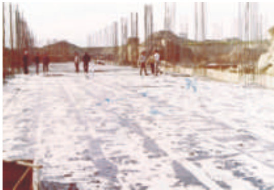
中央地下室底層地坪完成
