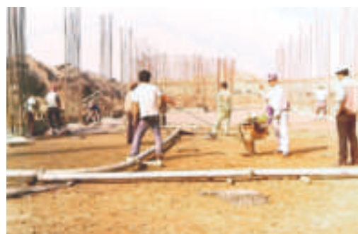
中央地下室地坪夯實
