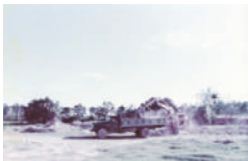
醫療大樓挖土施工實況
