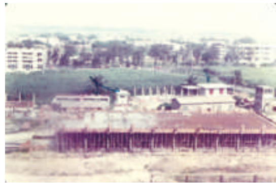
已完工污水處理場及變電房 施工中太平間、焚化爐、餐廳
