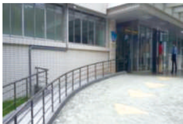
圖 14：出入口無障礙設置。
