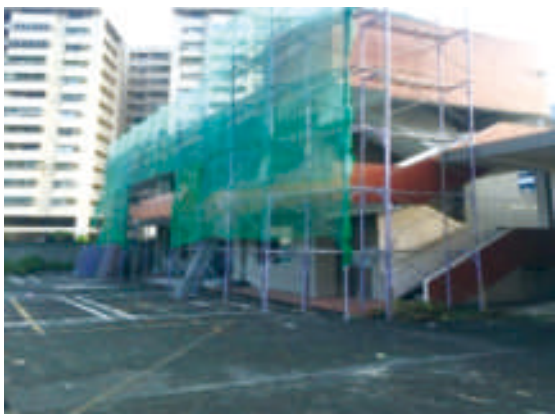
圖 4：整修中建物外觀
