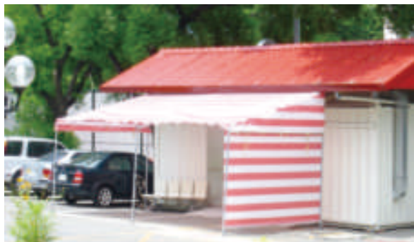
圖 1：發燒篩檢中心（室外 SARS 專診室）
