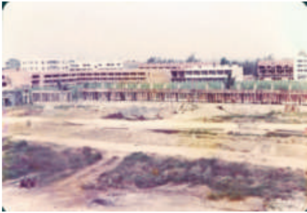
施工中衛材庫、危險品庫實況
